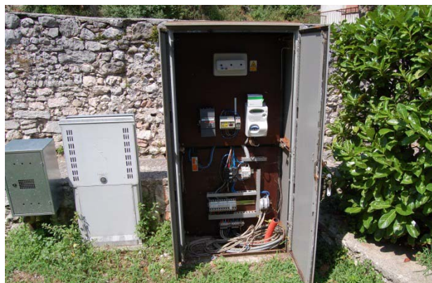
Figura 36: Particolare quadro elettrico I.P. (Q. NAGO 11)
