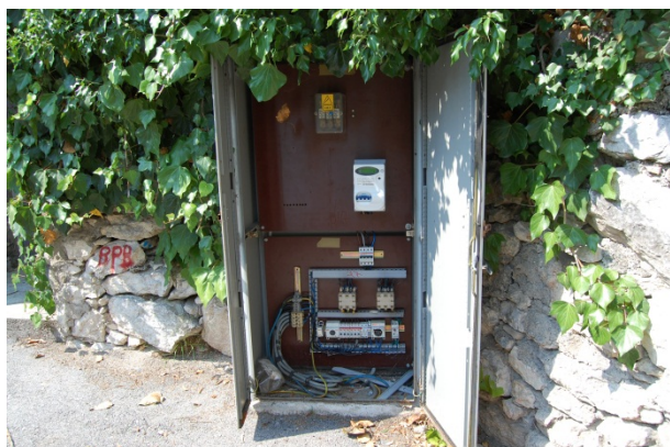
Figura 33: Quadro elettrico generale I.P. a Torbole (Q. TORBOLE 10)
