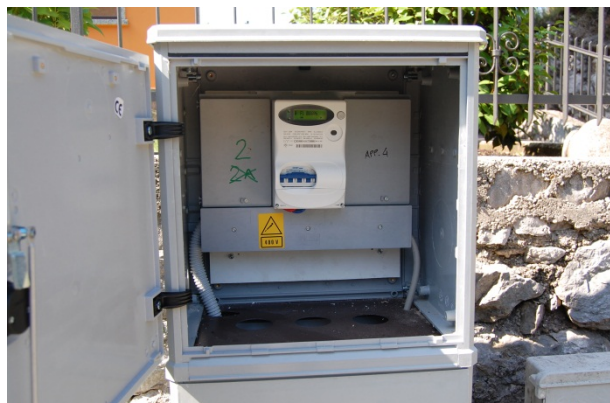
Figura 44: Particolare quadro elettrico I.P. (Q. NAGO 15)
