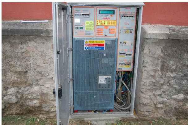
Figura 24: Particolare regolatore I.P. (Q. TORBOLE 05)
