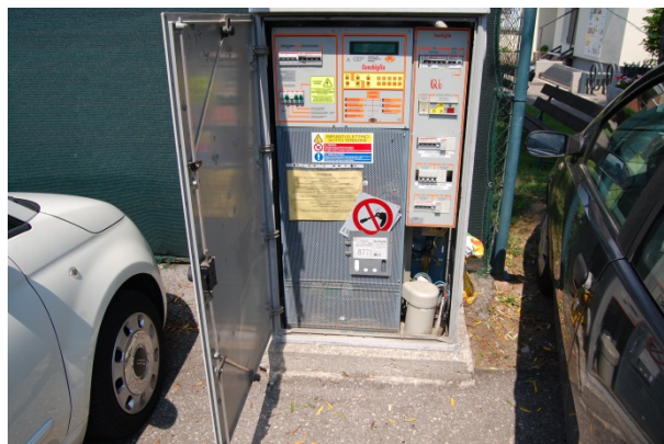
Figura 32: Particolare regolatore I.P. (Q. TORBOLE 09)
