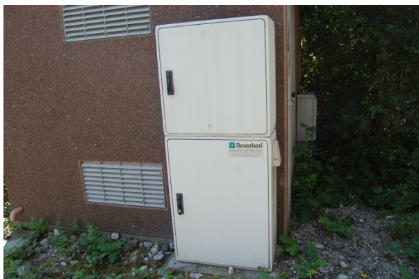
Figura 47: Quadro elettrico generale I.P. a Mala (Q. MALA 17)
