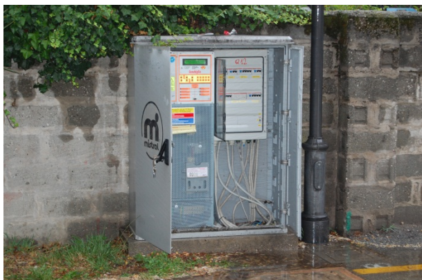
Figura 27: Quadro elettrico generale I.P. a Torbole (Q. TORBOLE 07)
