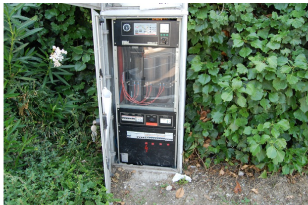
Figura 30: Particolare quadro elettrico I.P. (Q. TORBOLE 08)
