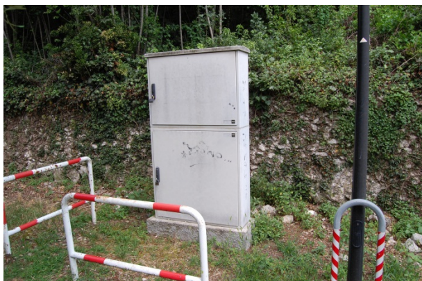
Figura 19: Quadro elettrico generale I.P. a Torbole (Q. TORBOLE 03)
