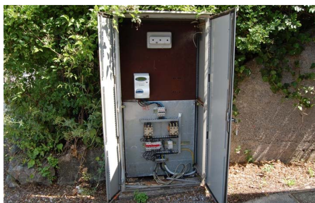
Figura 22: Particolare quadro elettrico I.P. (Q. TORBOLE 04)
