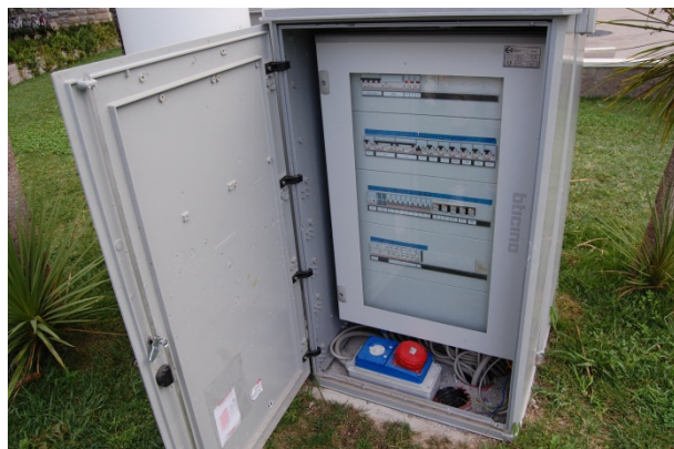
Figura 50: Quadro elettrico generale I.P. a Torbole (Q. TORBOLE 20)
