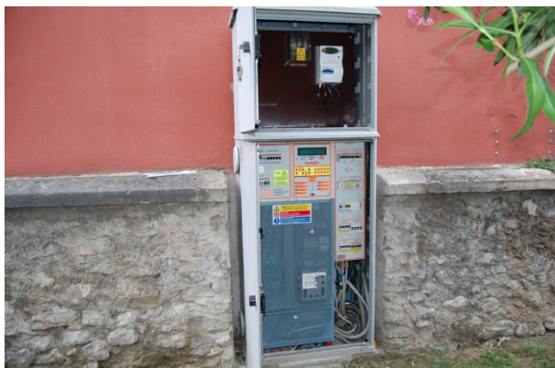
Figura 23: Quadro elettrico generale I.P. a Torbole (Q. TORBOLE 05)
