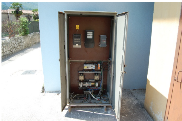
Figura 39: Quadro elettrico generale I.P. a Nago (Q. NAGO 13)
