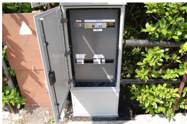
Figura 38: Particolare quadro elettrico I.P. (Q. NAGO 12)
