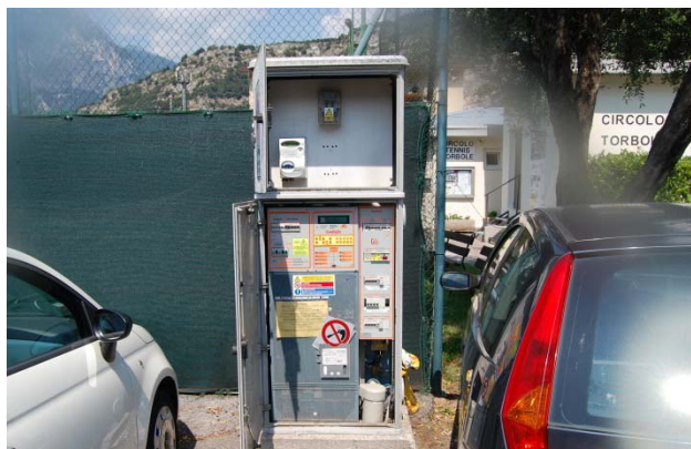
Figura 31: Quadro elettrico generale I.P. a Torbole (Q. TORBOLE 09)
