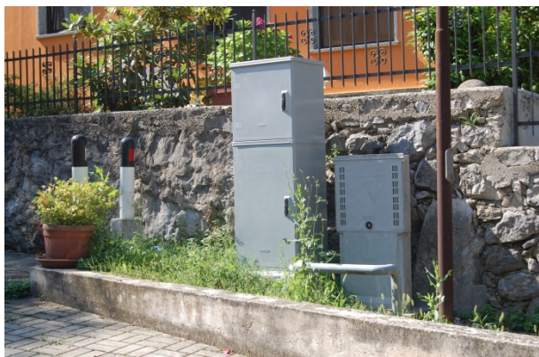
Figura 43: Quadro elettrico generale I.P. a Nago (Q. NAGO 15)
