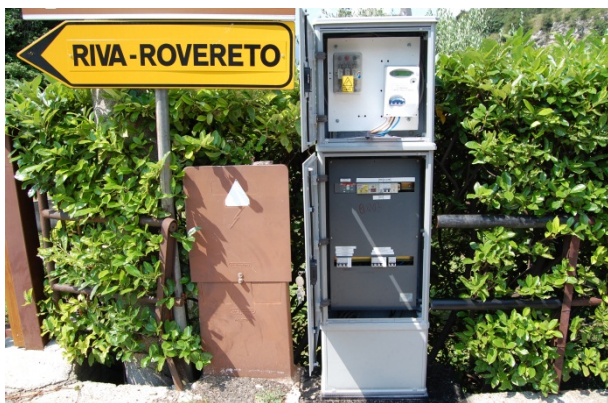
Figura 37: Quadro elettrico generale I.P. a Nago (Q. NAGO 12)
