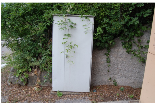
Figura 21: Quadro elettrico generale I.P. a Torbole (Q. TORBOLE 04)
