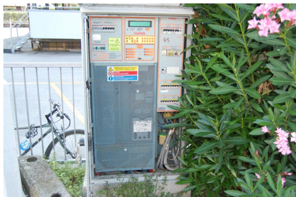
Figura 16: Particolare regolatore I.P. a Torbole (Q. TORBOLE 01)
