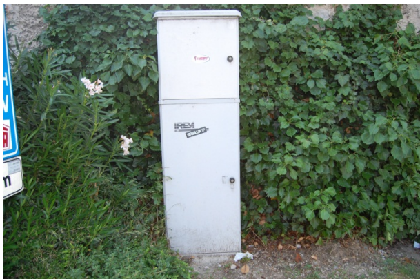
Figura 29: Quadro elettrico generale I.P. a Torbole (Q. TORBOLE 08)
